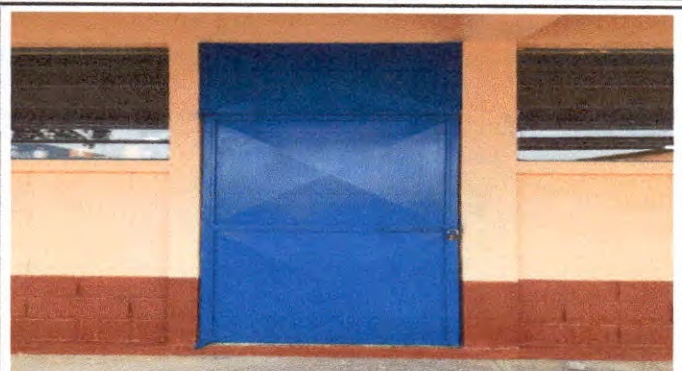
Foto 8: Puertas. Mantenimiento a estructura (lijado, cepillado, aplicación de pintura). En aulas, sanitarios y dirección del módulo 2 (parte de arriba) del establecimiento.
