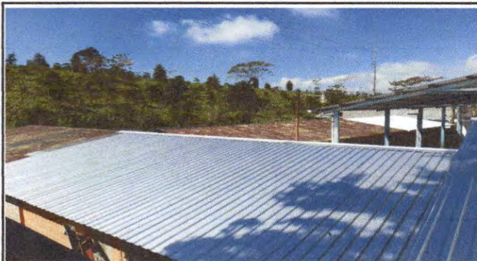
Foto19: Sustitución de lámina por lámina troquelada aluzinc calibre 26 en aula de primer grado modulo 1 del establecimiento.
