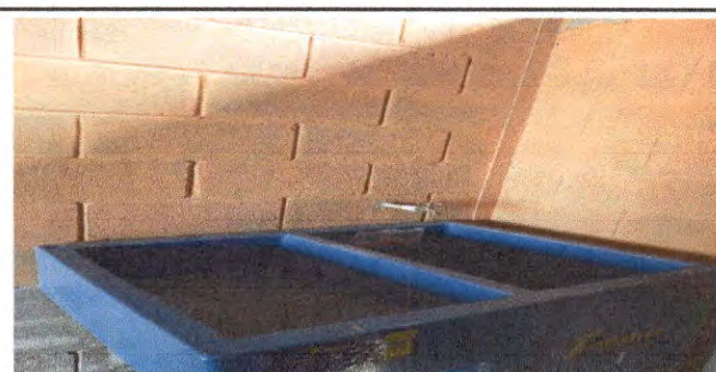
Foto 17. Sustitución de pila plástica de un lavadero. (incluye sistema de drenaje y conexión de agua) en area de cocina modulo 2 (parte de arriba)
