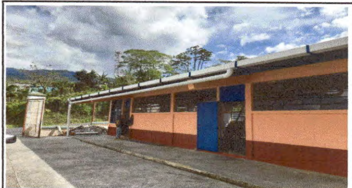
Foto 10: Sustitución de canales y bajadas de agua pluvial en módulo 2 (parte de arriba)
