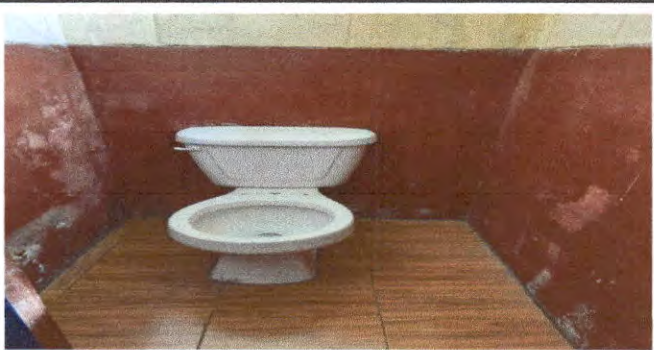
Foto 15: Sustitución de accesorios para descarga de agua en inodoro, en area de sanitarios de hombres y mujeres.
