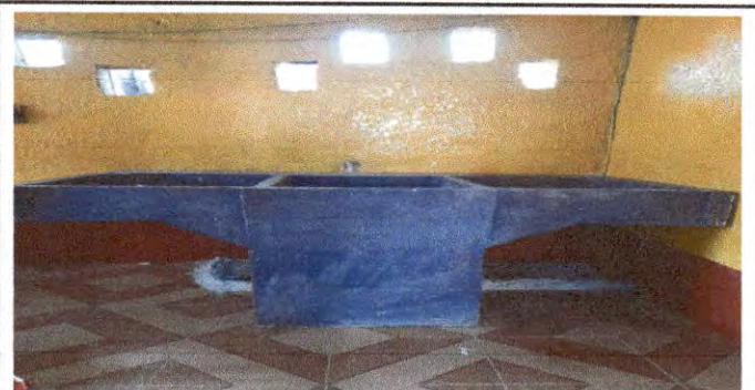
Foto 12: Instalación de pila nueva, mantenimiento de reposadera y sustitución de chorro en área de cocina.
